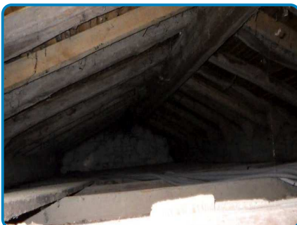
Maison principale 2ème étage Combles
