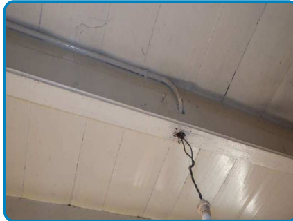
Anomalie B.3.3.7 a sur Install. n°1
