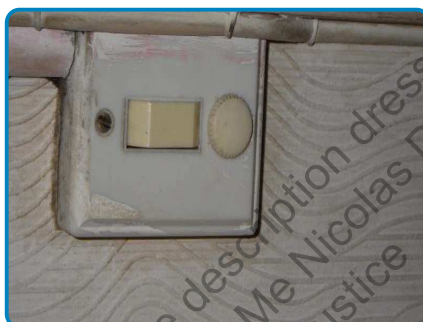
Anomalie B.8.3 a sur Install. n°1
