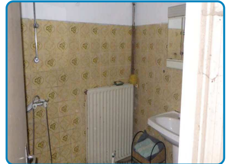
Maison principale Rez de chaussée Salle d'eau
