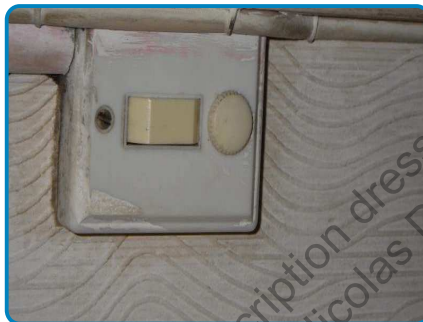
Anomalie B.8.3 a sur Install. n°1
