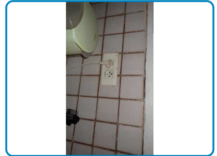
Anomalie B.3.3.6 a2 sur Install. n°1
